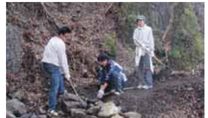
第2回道普請にて。崩壊した道の修復
